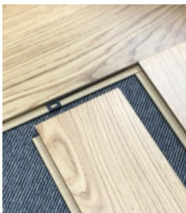
Dersom behov for å montere baklengs kan låsen fjernes som vist på bildet. Bruk hvitt PVAc lim i skjøten under montering.
